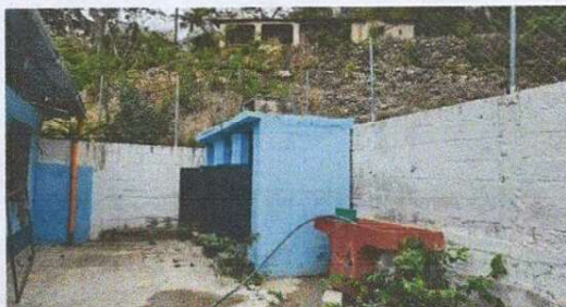
Foto 3: sustitucion de pila, por pila de dos lavaderos
