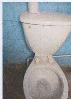
Foto 2: Sustitucion de accesorios de sanitarios
