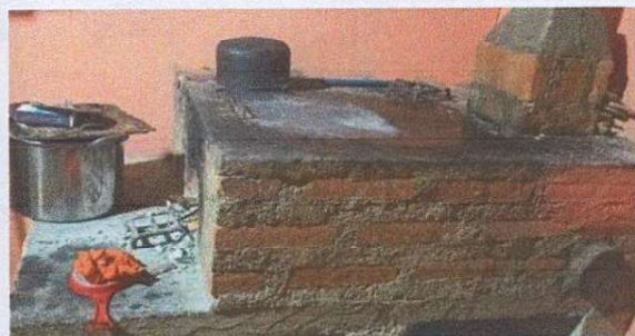
Foto 2: Refuerzo de mesón de concreto medidas de 80cm de altura, 60 cm De ancho y 5 metros lineales de largo. Sustrucion de estufa rural completa (chimenea y plancha de metal).
