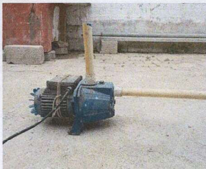
Foto1: Reparacion de bomba de agua, entrada y salida de 3/4" de 1 caballo de fuerza
