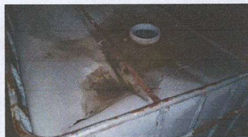
Foto 6: Sustrucion de tinaco, por tinaco rotoplas 5 toneles
