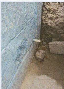
Foto 2: Sustitucion de tuveria de red de agua potable tuberia pvc 1/2"
